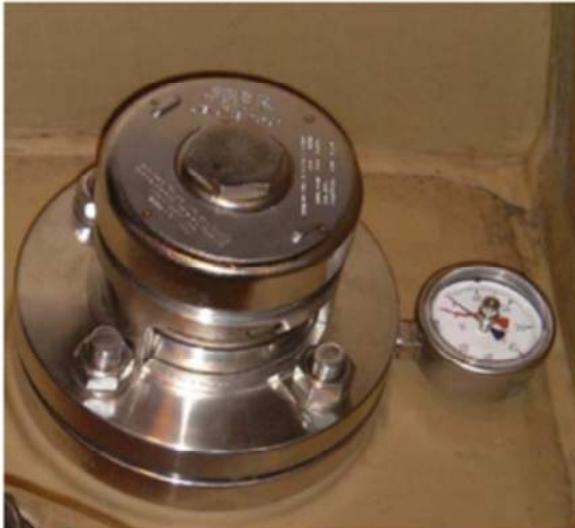
Típica Válvula de Segurança com manômetro instalado
